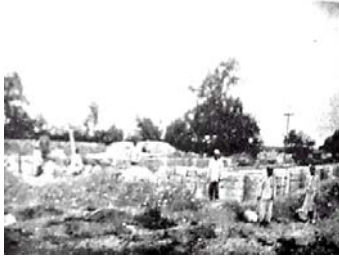
Baubeginn der Kirche in Kostheim
